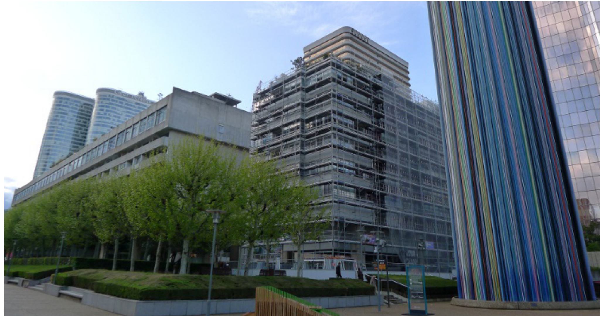
Pose d'isolation thermique extérieure et bardage en panneaux composites
